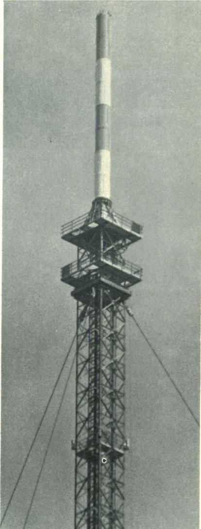
**Neuartige UHF-TV-Sendeantenne AT mit Rund- oder Richtstrahlcharakteristik, geringer Unrundheit des Horizontaldiagramms ( $\leq 2$  dB) und hoher Sendeleistung. Empfangs- und Sendantennen kleiner Leistung fertigen wir nach speziellen Wünschen.**
