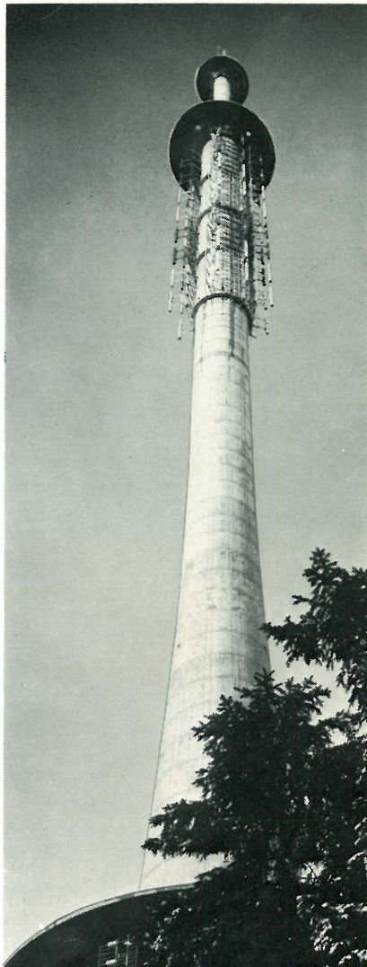
Sendeantennen-Anlage für VHF-FM-Rundfunkbereich II und Fernsehbereich I.
