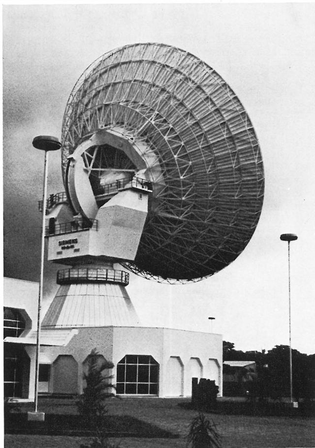
von 23 Millionen DM, die im Auftrag der Postverwaltung von El Salvador in 18 Monaten Bauzeit errichtet wurde, konnte jetzt ihren Betrieb aufnehmen. Die Parabolantenne (unser Bild) mit einem Durchmesser von 32 Metern ist auf den Nachrichtensatelliten Intelsat IV-A über dem
